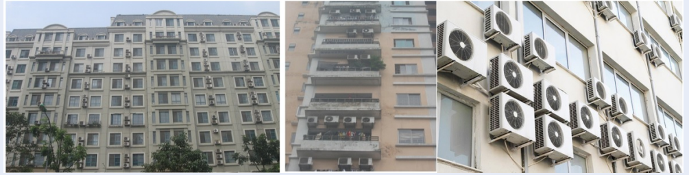
Hình 1: Lắp đặt dàn nóng điều hòa không khí của một số tòa nhà cao tầng 1
