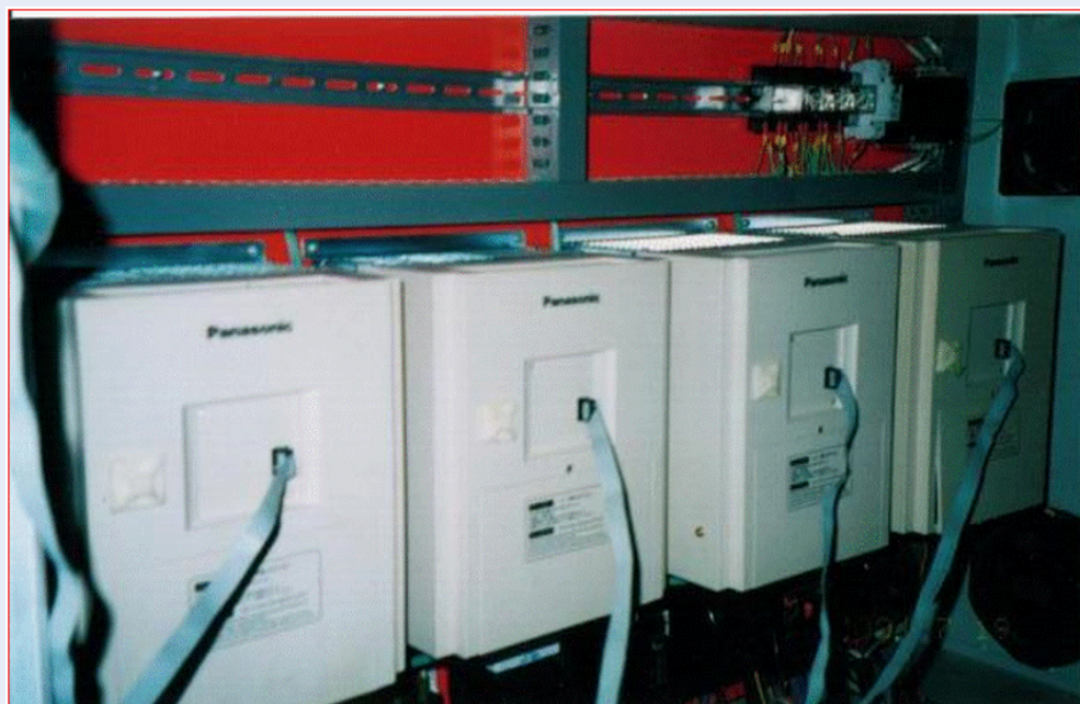
Hình 11: Biến tần và bộ PLC đã được lắp đặt cho hệ thống Chiller
